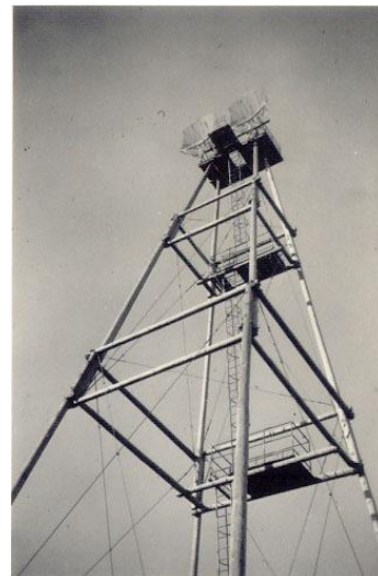
4. Eksperimentelt tårn i Kongelunden, opstillet i samarbejde mellem Storno og Mikrobølge-laboratoriet på DTH; ca. 1950
